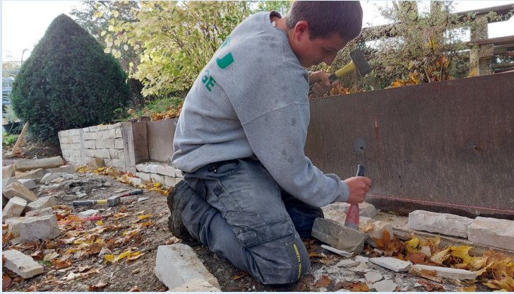
Muret en pierres calcaire
