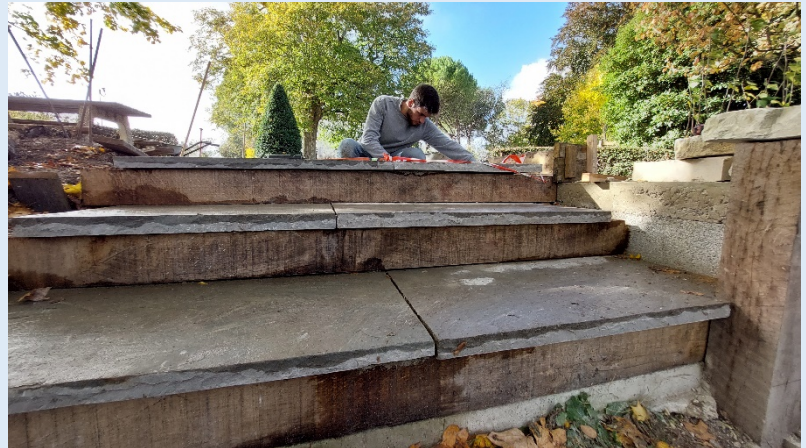
Escalier associant bois et pierre naturelle
