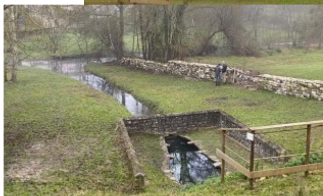
Lavoir de la Bonnauderie-Port d'Envaux-
