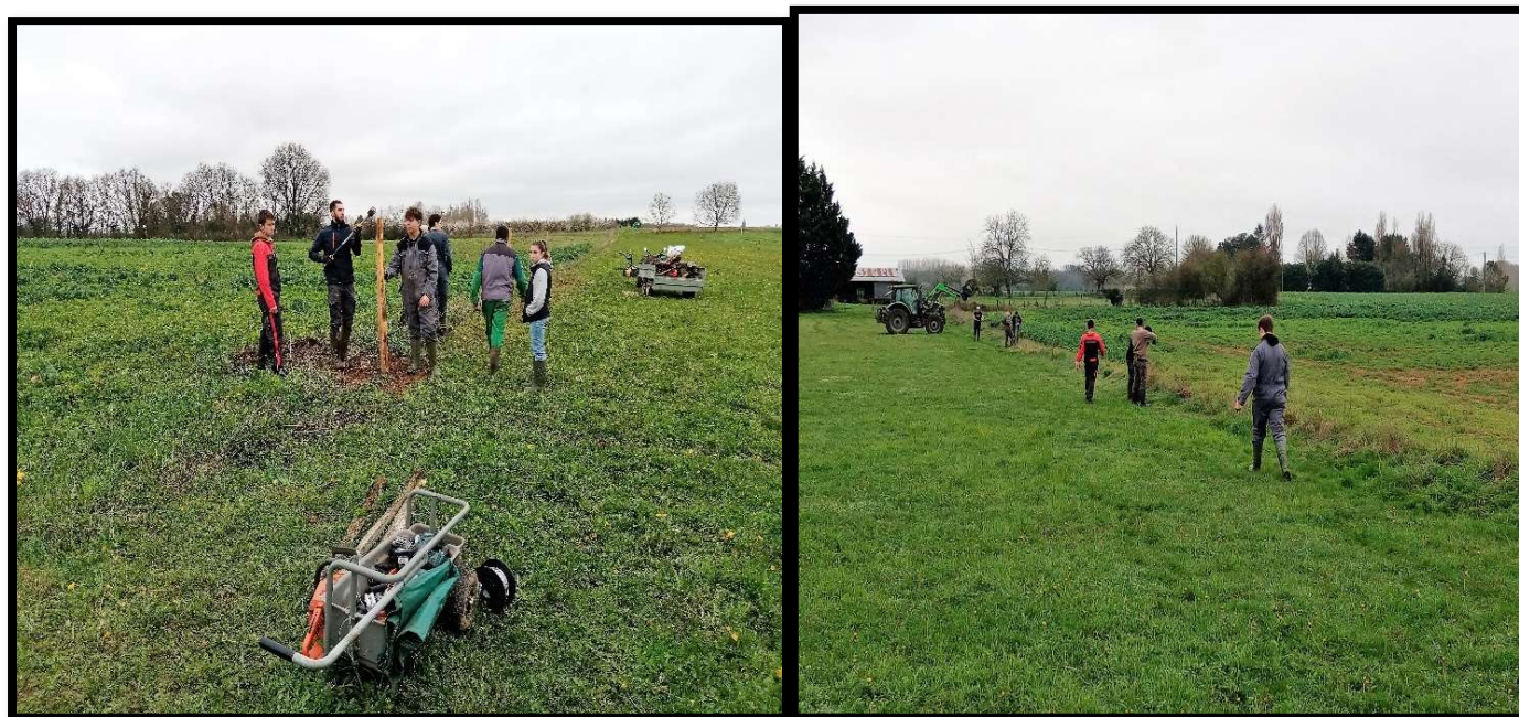
Réalisation d'un chantier de mise en clôture EARL Le moulin de Tetaud à Corme Royal 17600 (Mars 2023)
