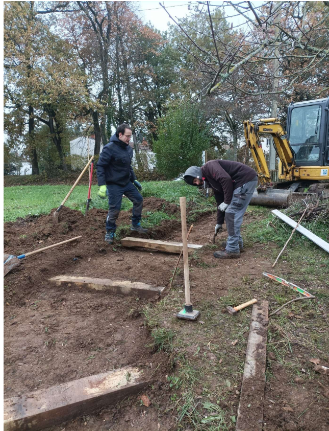
Réfection des gradines
