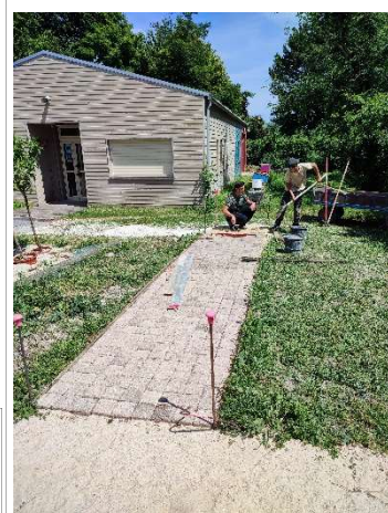
REALISATION D'UN PAVAGE
